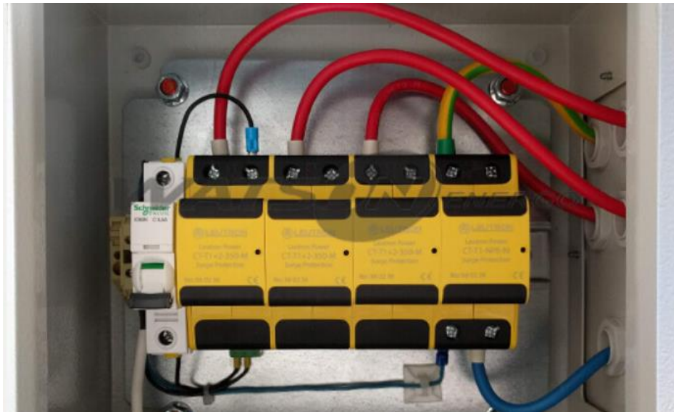
Рис. 2. Внутрішній блискавкозахист приватного будинку
