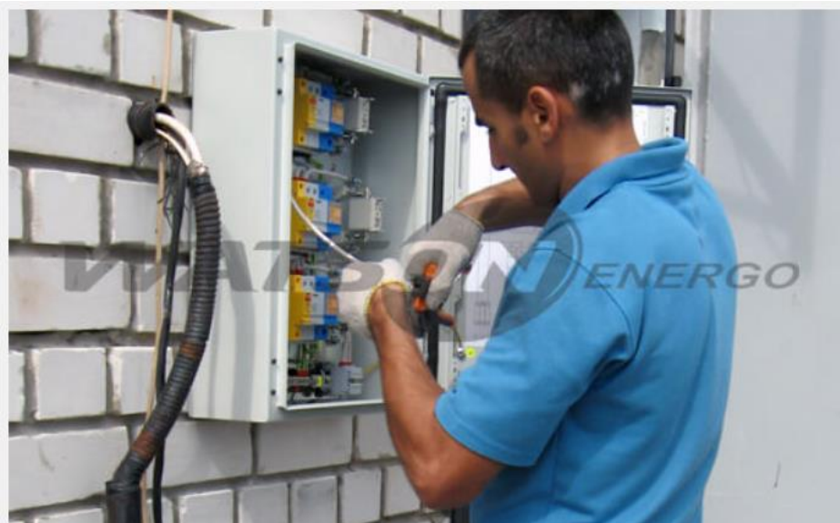
Рис. 3. Монтажна зборка внутрішнього блискавкозахист приватного будинку
